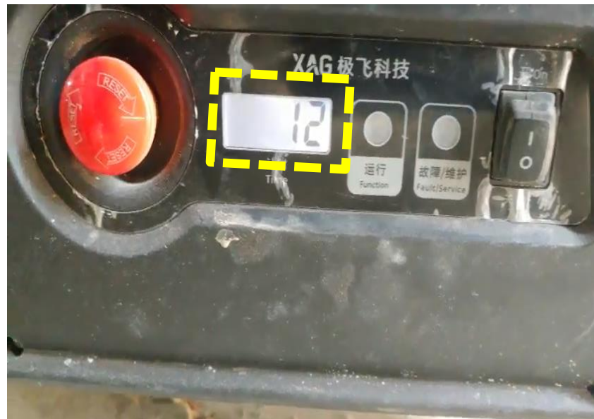
Màn hình LCD của máy phát điện. Ví dụ trong hình báo máy đã chạy 12 giờ.
